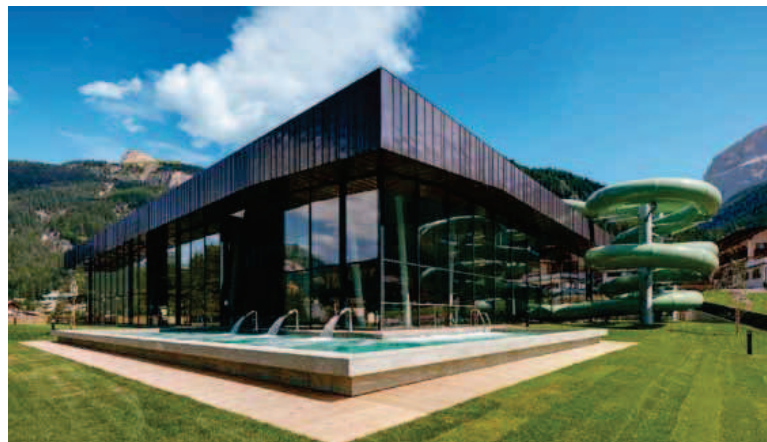
La piscina di Canazei tra i lavori di Zanetti
